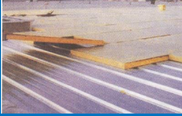
Cam yünü levhaların yerleştirilmesi
