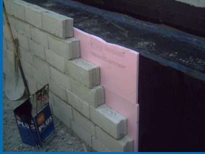
Emülsiyon Uygulanmış Temel Duvarı
