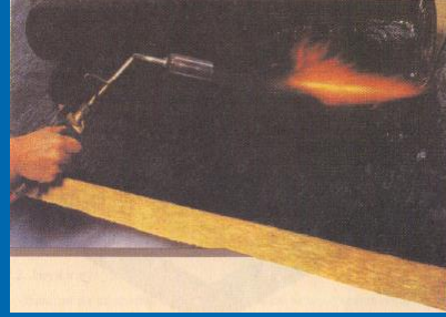
Cam yünü levhalar üzerine Şalümo alevi ile bitümlü Örtülerin yapıştırılması
