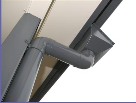
Hazneli bir çatı oluğu
