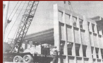
Prefabrik Duvarın Vinçle Yerleştirilmesi
