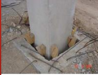
Kolonun sokete yerleştirilmesi
