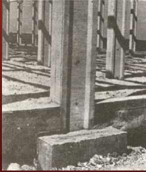
Kolonun sokete yerleştirilmesi
