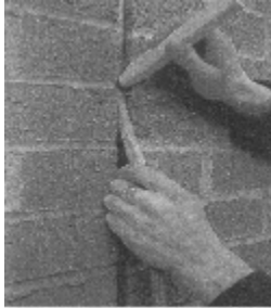
Tuğla Duvar Dilatasyonu
