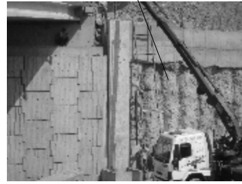
Çakma Kazıkla Yapılmış İstinat Duvarı
