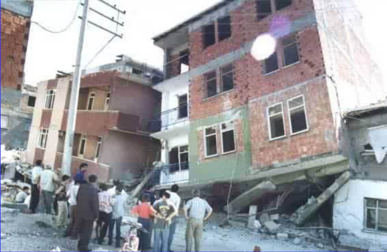
Zemin kat kolonlarında mafsallaşmalar
